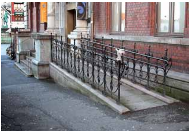
Rampe ved inngangen til Turistinformasjonen i Bergen. Rekkverket er gitt en utforming som harmonerer med den gamle bygningen, og på innsiden er håndlister i to høyder på begge sider. Foto: Ingfrid Bækken,
