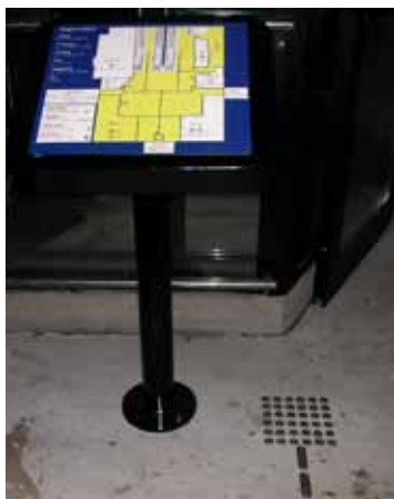
Ledelinjene på Jernbanestasjonen i Bergen leder blant annet frem til taktile informasjonsskilt med punktskrift. Skiltene er imidlertid plassert ved slutten av ledelinjene, og ikke ved inngangen der ledelinjene begynner. Foto:
