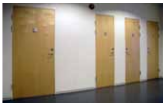
Det er god kontrast mellom gulv, vegger og dører ved toalettene i Bergen Byarkiv.
