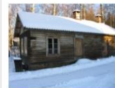
Gjørtlerverkstedet. Sinklaftet bygning i en etasje og loft.
