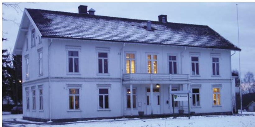
Sørby – det gamle kommunehuset i Våle.
