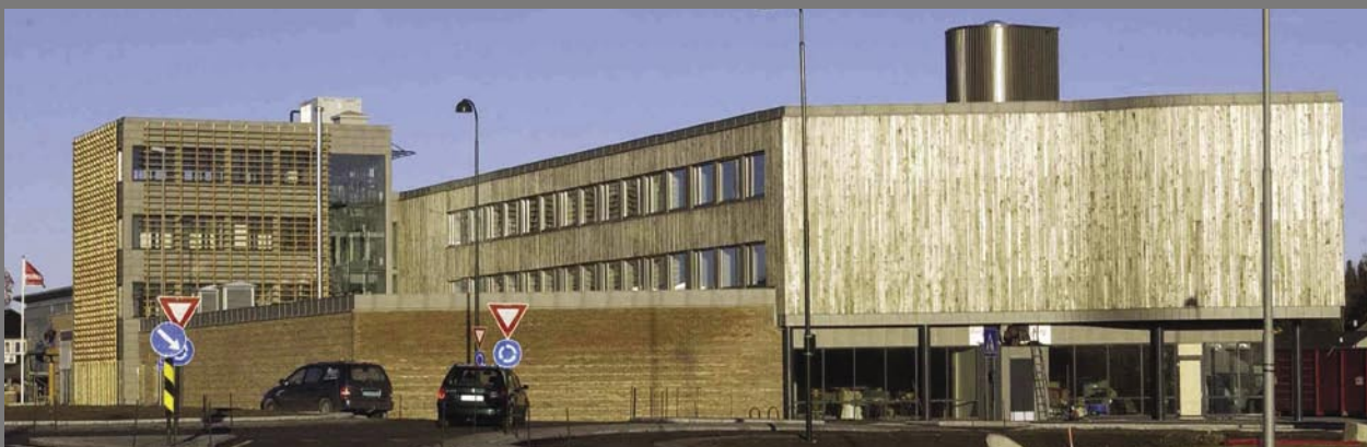
Re kommunes nye rådhus, sentralt plassert i Revetal sentrum.
